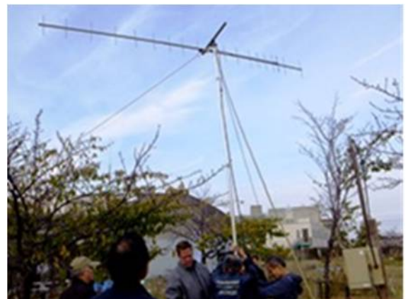
F9FT アンテナを設営中
